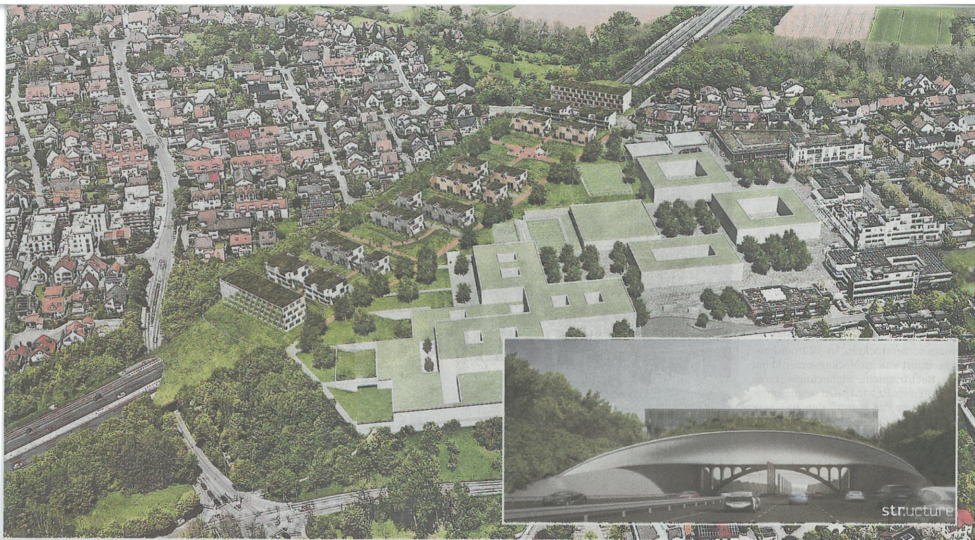
Der Deckel über der A 81 soll eine Schnittstelle zwischen dem Ortsteil Geisingen (links der Autobahn) und dem neuen Zentrum mit dem Neubau der Oscar-Paret-Schule bilden. Bürogebäude sind als zusätzlicher Schutz vor Lärm von der Straße vorgesehen (kleines Bild). Foto/Entwurf: Stadt Freiburg
